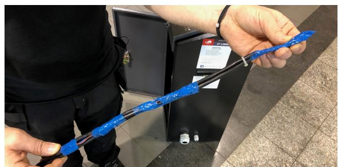
Trek strømkabler og hydraulikkslange gjennom strekkavlasteren.
