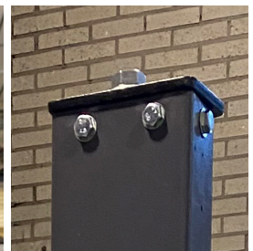
8. Aseta tolppakannet ja tarkista, että vaijerin reikä on yhteensopiva vaijeripyörien kanssa. Kannen alapuolella on oltava myös mutteri ja aluslevy.
