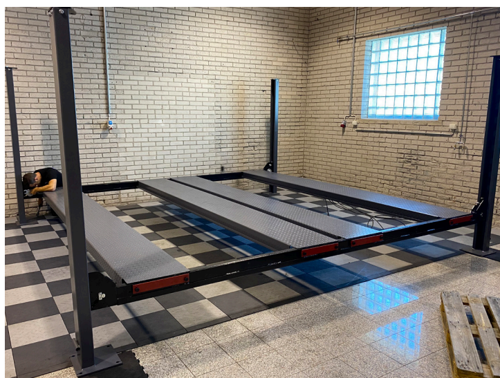
17. Løfter rampe to, tre og fire på plass.
