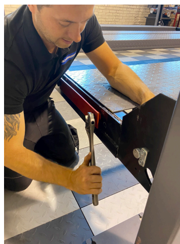
16. Bolt fast rampen og flatjernet for oppkjøringsrampene.
