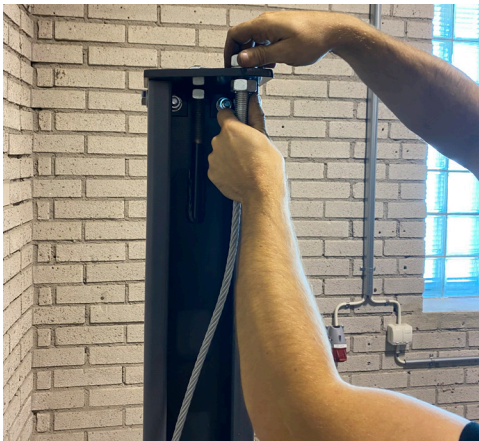
20. Fastgør wiren i søjlen, men kun så meget, at møtrikkerne har gevind. De skal justeres ind senere og så skal der være plads til justering.
