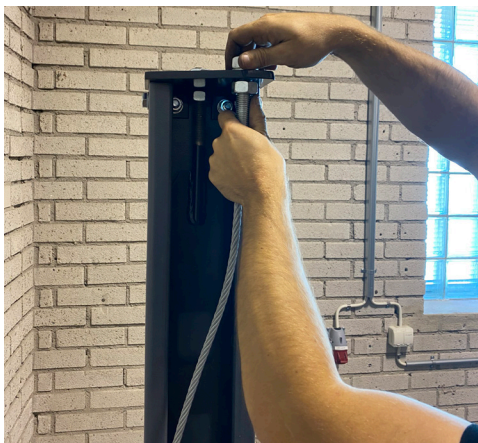
20. Säkra vajrarna i pelaren men bara så muttrarna har gängor. De ska justera in senare och då måste det finnas justermån.
