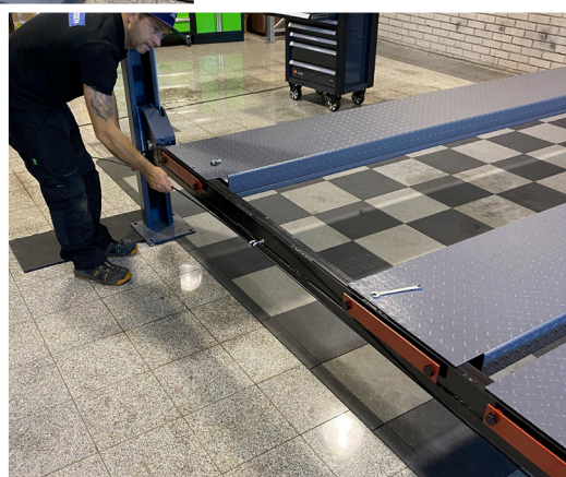
31. Monter øgleskruene for de lange leddene, og trø dem gjennom.
