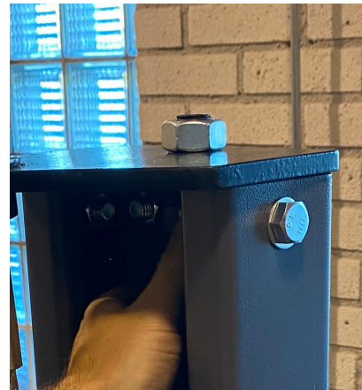
10. Asenna rauta mutterilla niin, että mutteri on kierretty koko kierteen pituudelta sisään mutta ei enempää.
