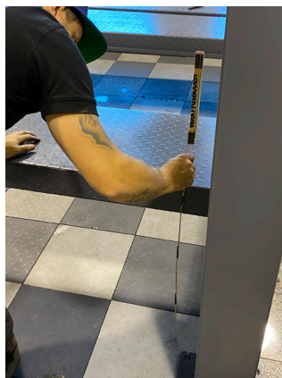
32. Hev løfterampene og legg dem på sperren i samme høyde i alle hjørner. Juster sperretrinnene om nødvendig, og stram deretter vaierne.
