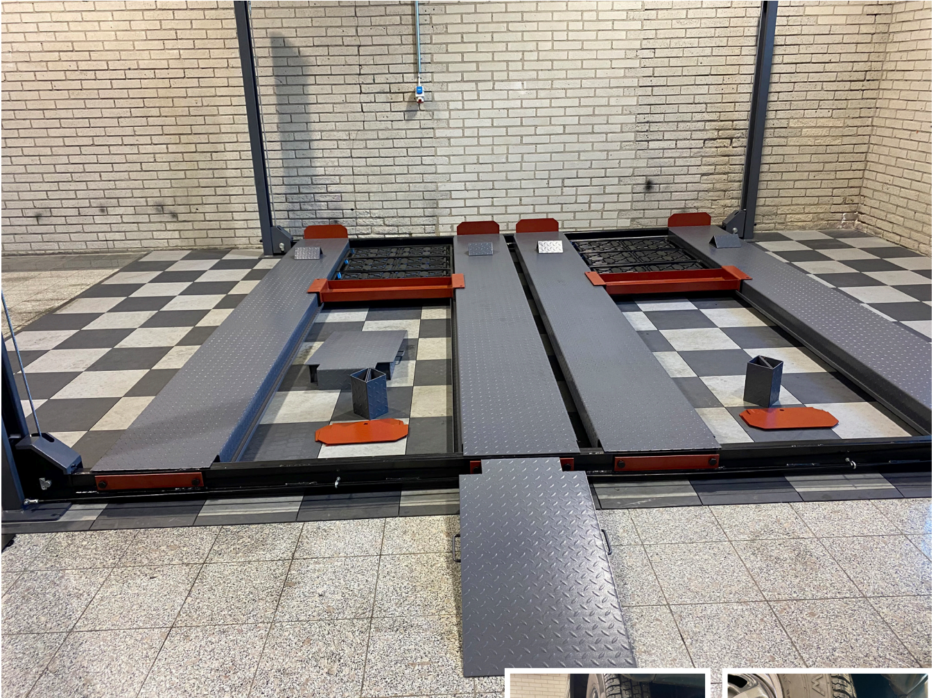
33. Pura ajorampit, pyörien pysäyttimet, pysäytinlevyt ja putoamissuojat.
